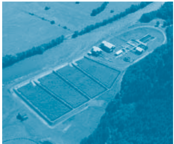
Les depuradores biològiques verdes són feixes plantades de canyís, les arrels del qual es converteixen en un filtre natural per a depurar l'aigua residual.
