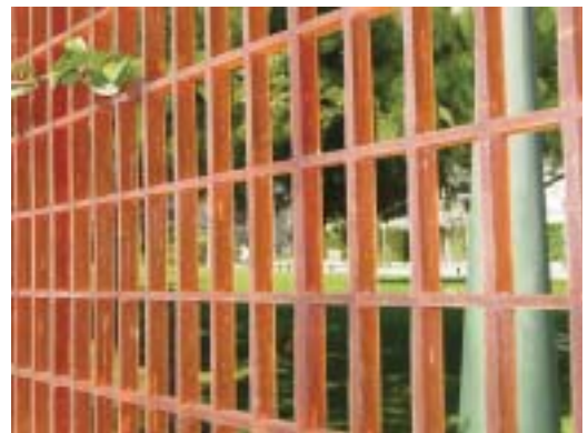
Tanca de vidre reciclat, un bon exemple de com aprofitar els materials residuals i evitar el problema dels abocadors d'escombraries.
