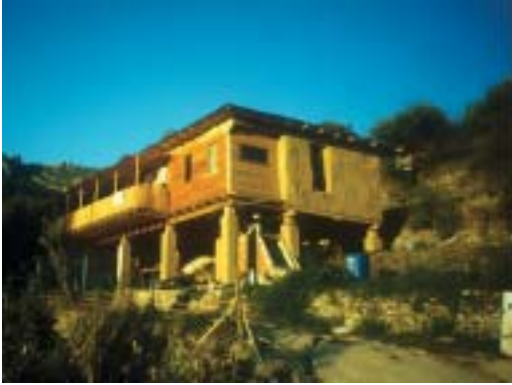
Antic o nou, l'art de construir amb materials naturals és una opció possible i encertada per a evitar els danys dels nostres habitatges al planeta. A la imatge, casa de palla i fusta aixecada a Alacant.
